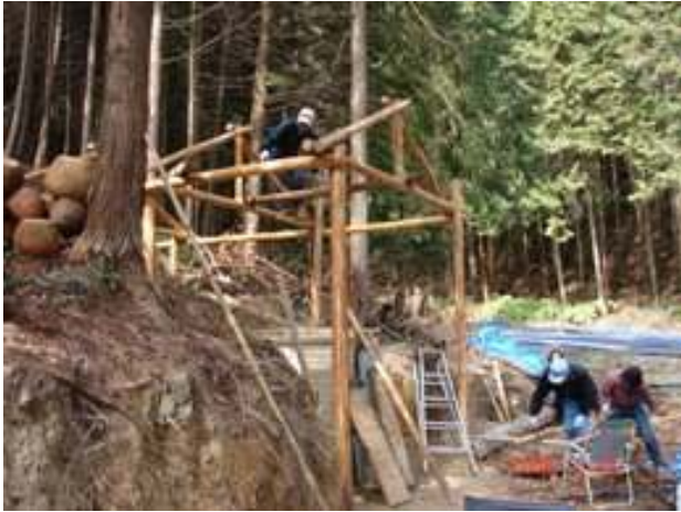
棟上げ作業追い上げ中
