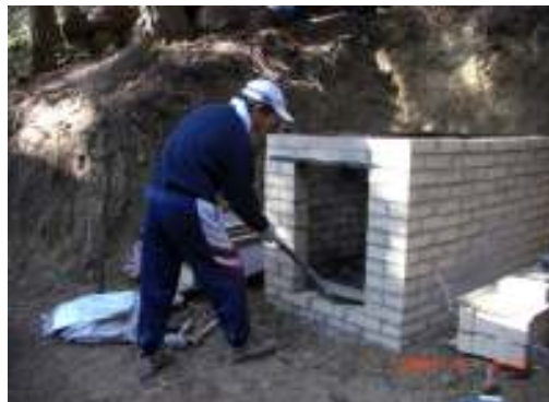
窯内の焼却灰取り出し
