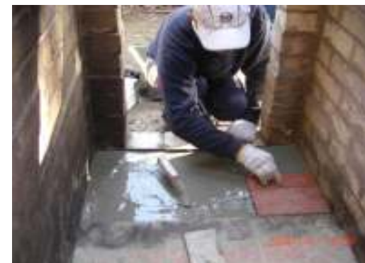
窯の焚口部分、床煉瓦タイル張り
