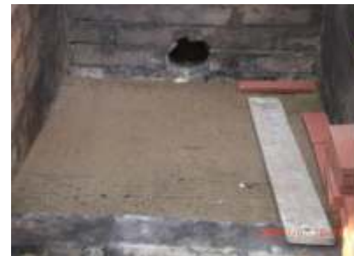
窯内の床、粘土突き固め
