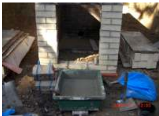
窯内の床下地完了、煉瓦タイル張り準備
