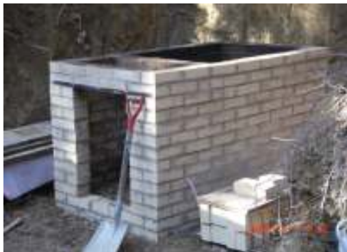
耐火煉瓦壁部分、窯内仮焼き完了
