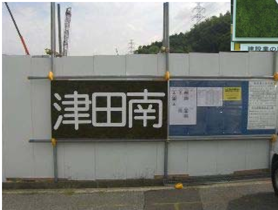
大阪府枚方市津田南町工事現場
